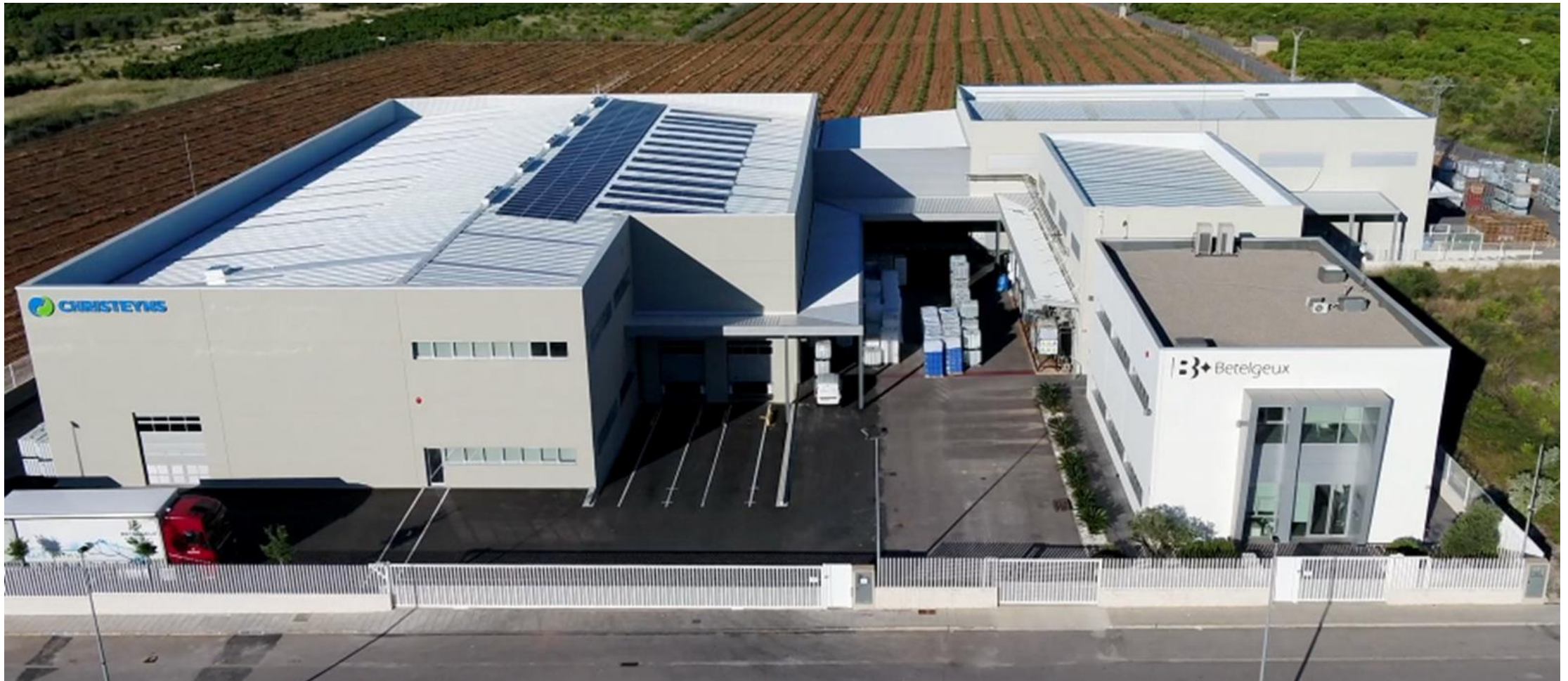
Figura 1. Instalaciones de Betelgeux – Christeys en Ador (Valencia – España)
